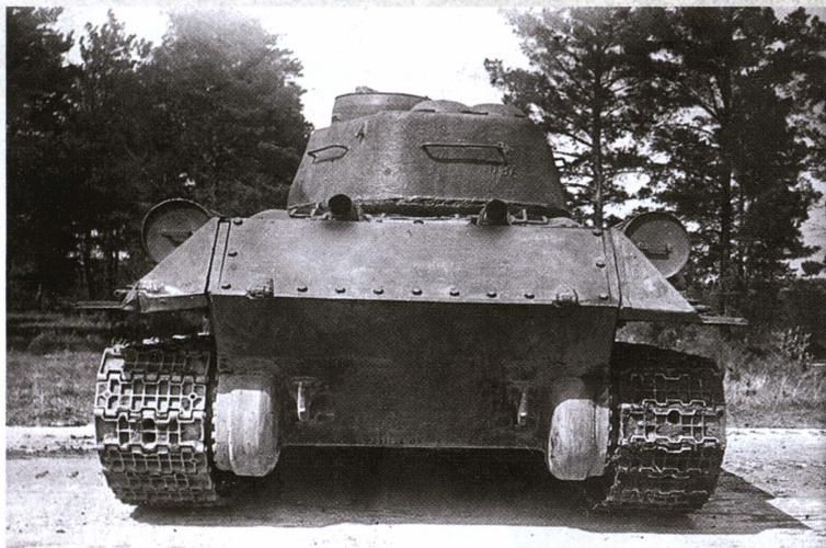
Танк Т-34-85М второго варианта, вид сзади. Хорошо видно, что корма машины отличается от серийного Т-34-85.
